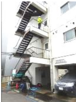
▲ 外階段を利用して工事
